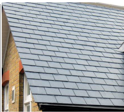
Toiture en ardoise
