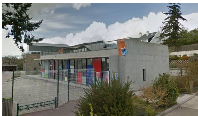
Ecole mixte l'Orange Bleue (face sud béton)
